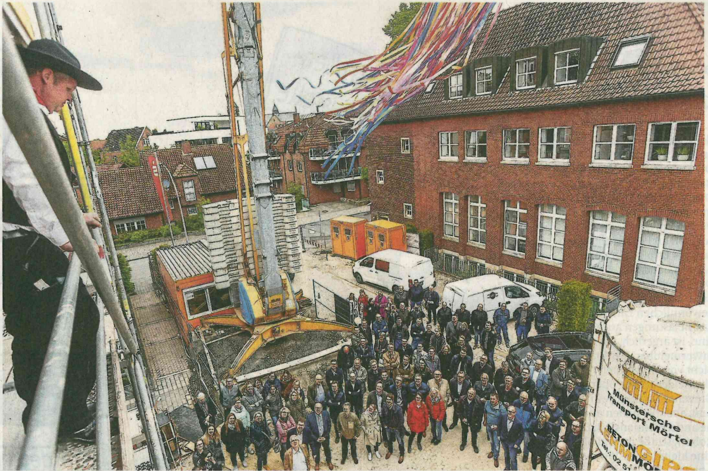
Der Richtkranz wurde unter dem Applaus der Gäste und künftigen „Bewohner“ der Büroräume hoch gezogen.
